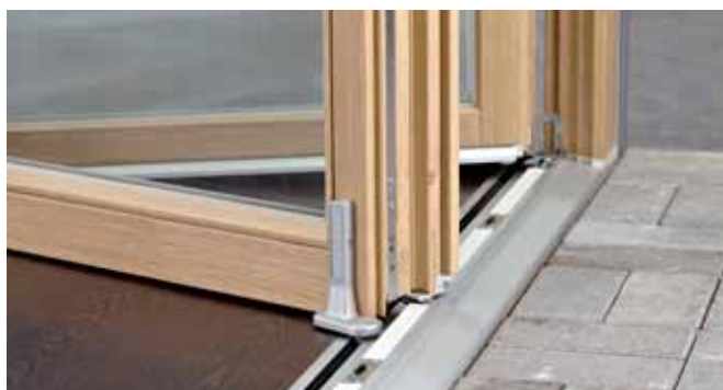
A nagy és nehéz szárnyakat könnyedén lehet eltolni, így maximálisan nagy és akadálymentes átjáró jön létre
